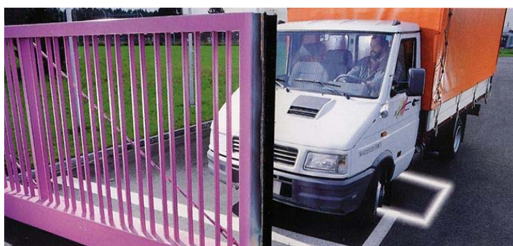
Figura 15 - Detalhe de veículo passando por detecção de um loop indutivo (representado pela faixa branca sobre o solo).
